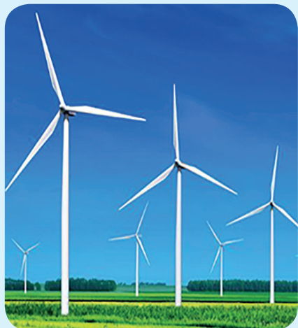
Мал. 23. Вітряна електростанція
