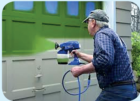
Мал. 35. Робота фарбопультотом
