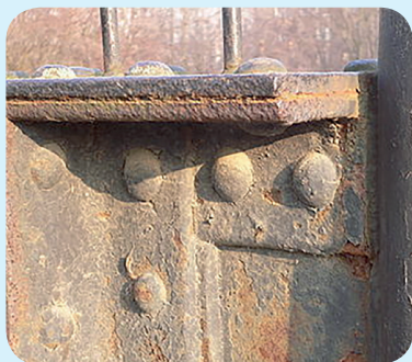
Мал. 131. Заклепкове з'єднання
