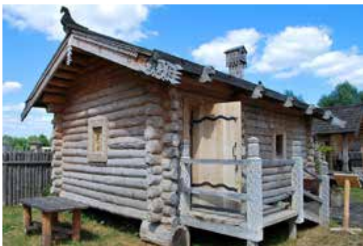
Будинок зі зрубу (реконструкція)
